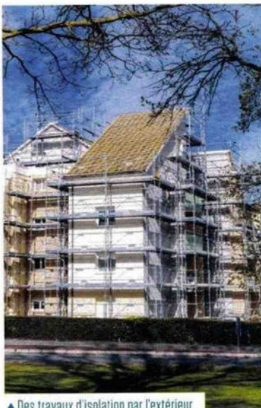
▲ Des travaux d'isolation par l'extérieur.
